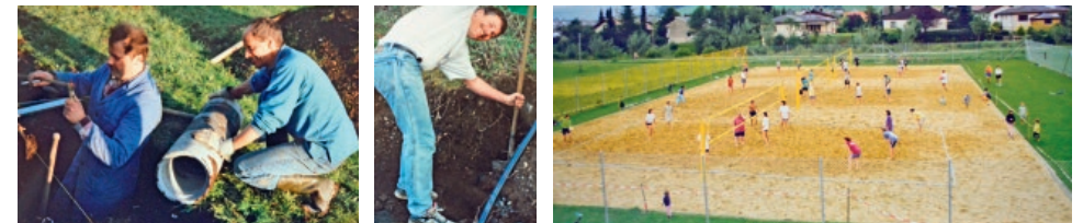
Impressionen des Baus vom 17. April 1997 (Aushub) bis 10. Juli 1997 (Umgebungsarbeiten).
